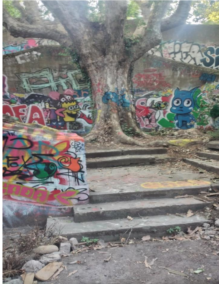
Lavoir Saint Thomas : grille à prévoir devant l'escalier
