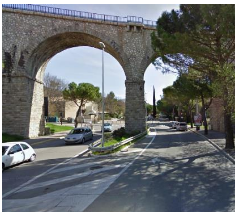
Passage sous le viaduc ferroviaire de l'Arc de Meyran
