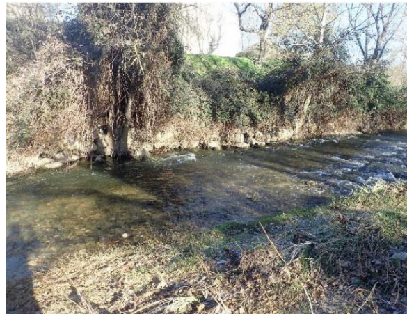
Déchaussement enrochement rive droite en amont du pont Marcel Roche
