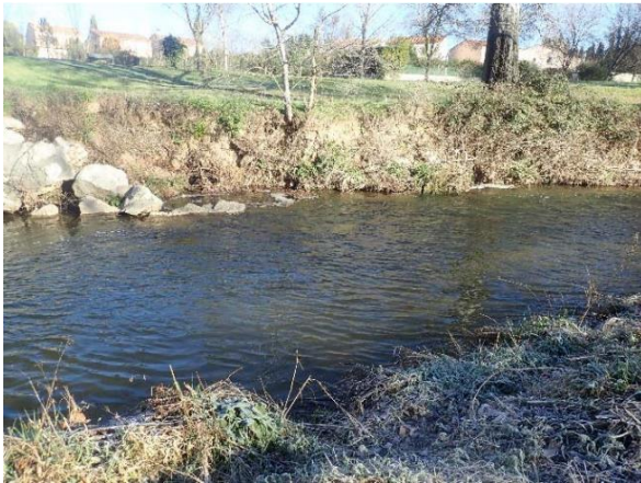
Déchaussement enrochement du rejet pluvial en rive droite
