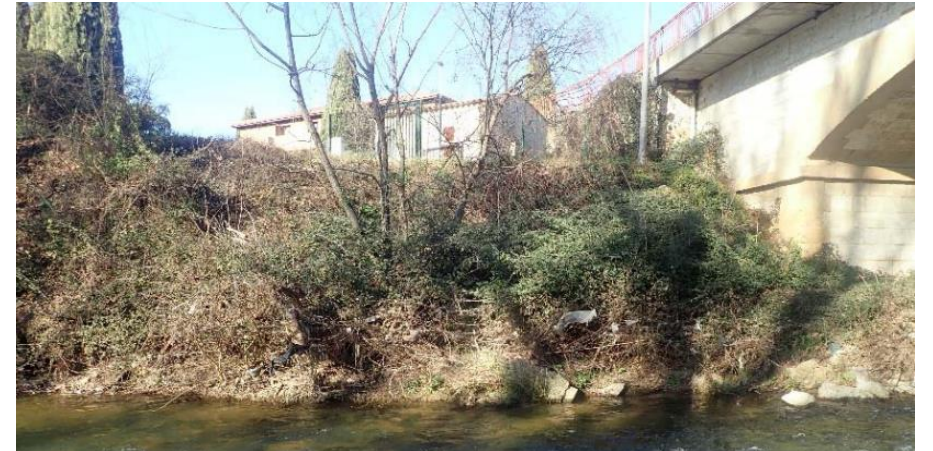
Erosion en pied de berge du poste de relevage des EU, aval pont Marcel Roche
