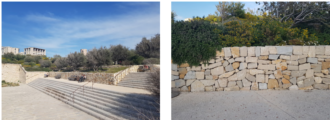
les murs de soutènement en pierre sèche au Musée des civilisations de l'Europe et de la Méditerranée, Marseille
