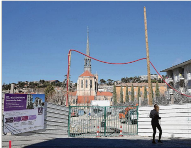
Le site de la polyclinique du Parc Rambot tel qu'il apparaît aujourd'hui, les bâtiments rasés. Les fondations sont en train d'être creusées. À droite, une vue de la résidence telle que la dessinent le promoteur, la Cogedim, et l'architecte aixois retenu, François de Alexandris.
