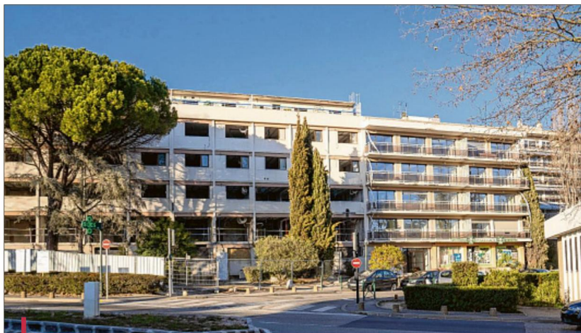
À gauche, le bâtiment en chantier dont la façade devra rigoureusement être réhabilitée pour s'harmoniser avec les autres de la résidence.
