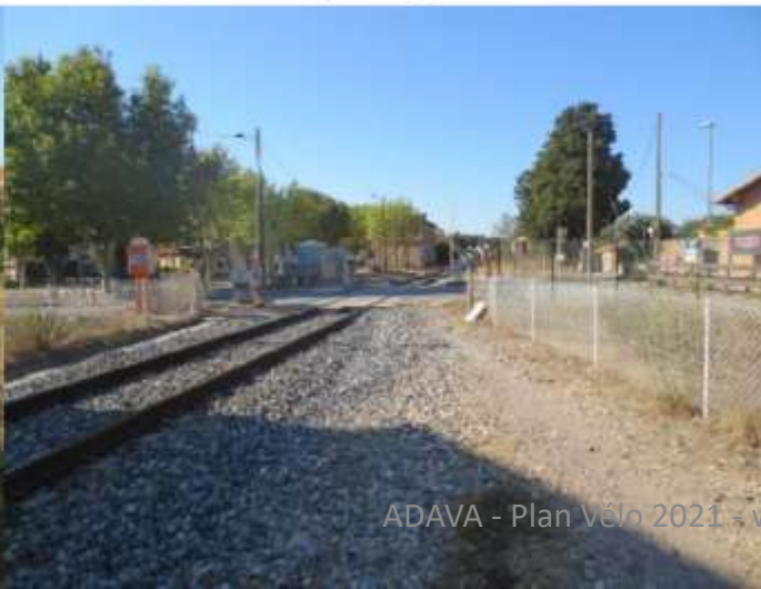
Débouché au passage à niveau PN9
